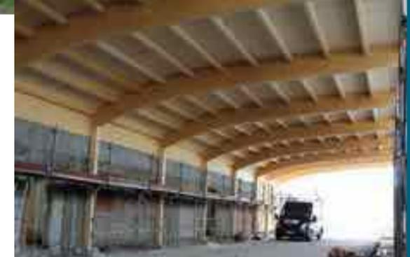
Der Speisesaal zwischen den Fachräumen und der Ganztagschule wird durch eine geschwungene Holzkonstruktion aus vorgefertigten Leimholzbindern überspannt. Mit dem Einbau der Fenster und der Beplankung des Daches wird die Hülle des Gemeinschaftshauses geschlossen. Im Herbst 2015 beginnen dann planmäßig die Arbeiten zum Innenausbau.
